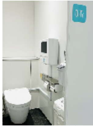
OiTr（オイテル）が設置された 東京工芸大学キャンパス館内のトイレ
